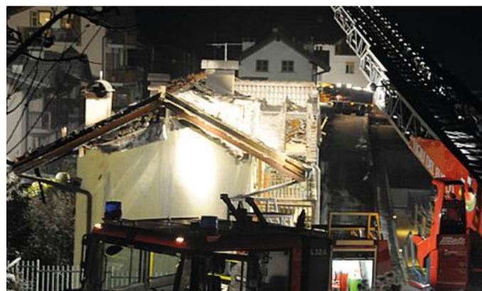
L'intervento dei vigili del fuoco a Montevaccino
